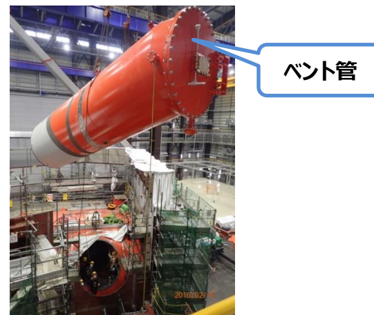
ベント管据付
