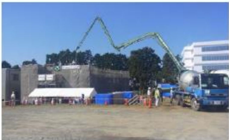
写真1 コンクリート打設状況
