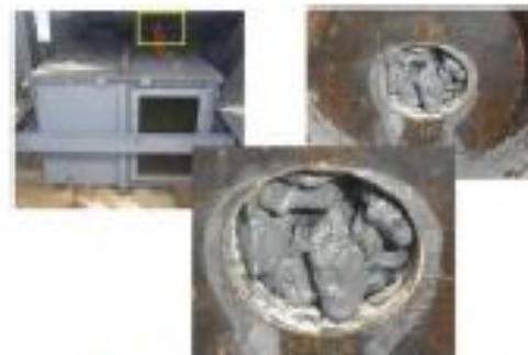
写真2 S/C損傷孔の閉塞状況
