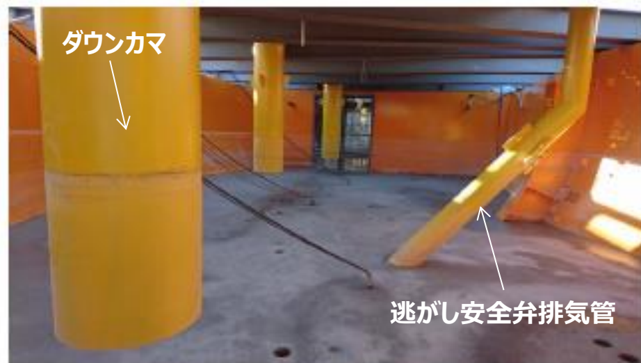
写真4 S/C内コンクリートの充填状況
