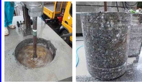
コアボーリングによるウェルカバー開口簡易試験(2014年度)
