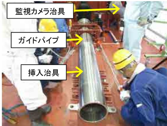
図4.3-7 350A用ガイドパイプ挿入時の状況
