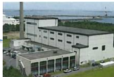
既存分析施設
