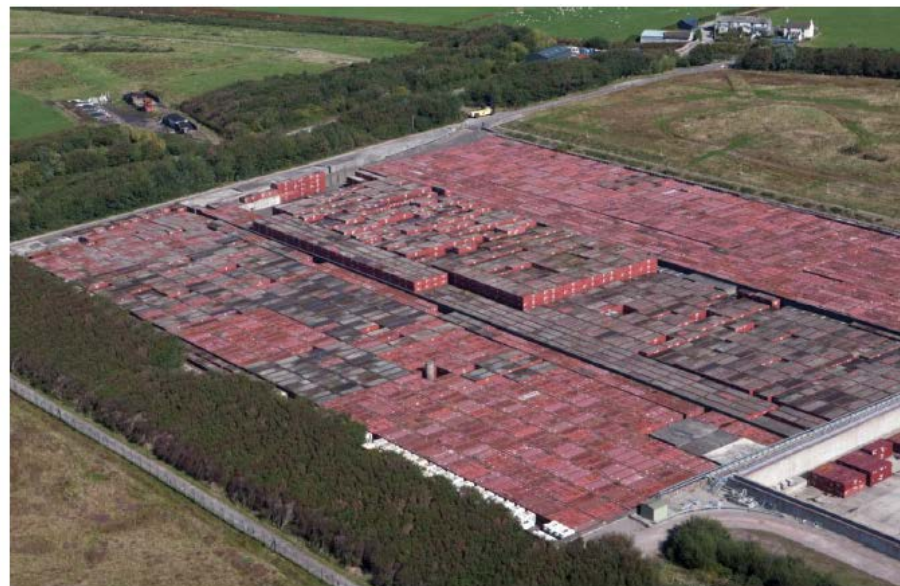
LLWR処分場に設置されたコンテナ廃棄体
