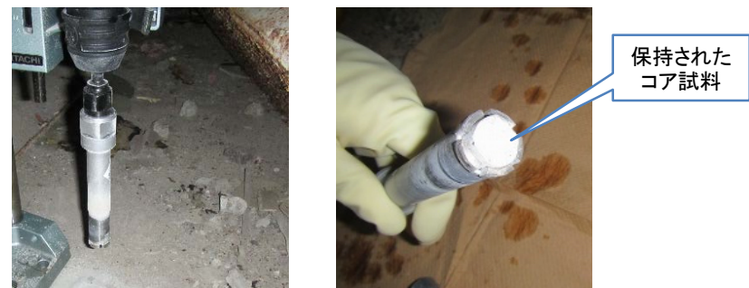
図3 4号機原子炉建屋内での採取作業
