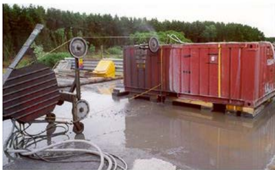
固化済みコンテナの切断
