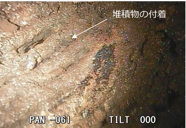
撮影場所A グレーチング脱落部②
