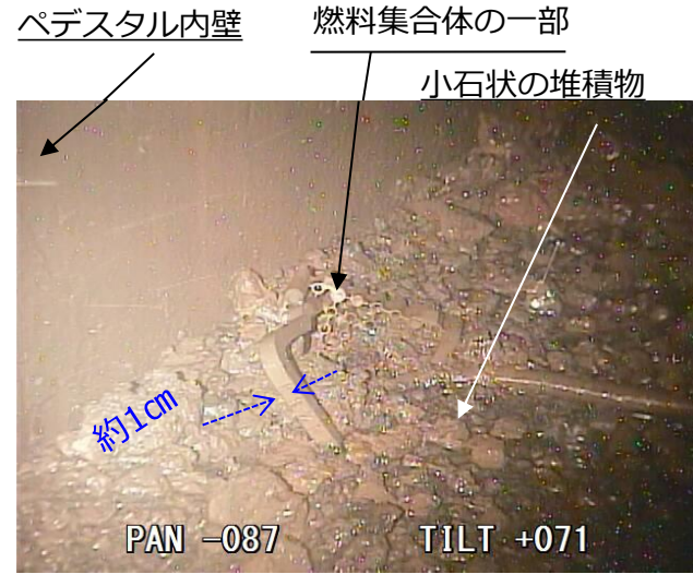
撮影場所C ペDESTAL底部
