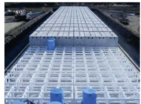
セシウム吸着塔一時保管施設 (ボックスカルバート)
