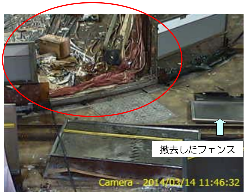
図4 フェンス撤去後
