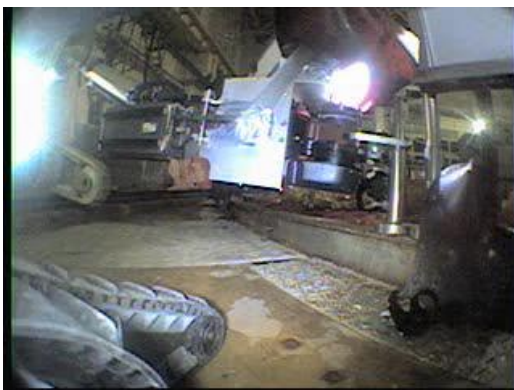
図2 フェンス脚部切断前
