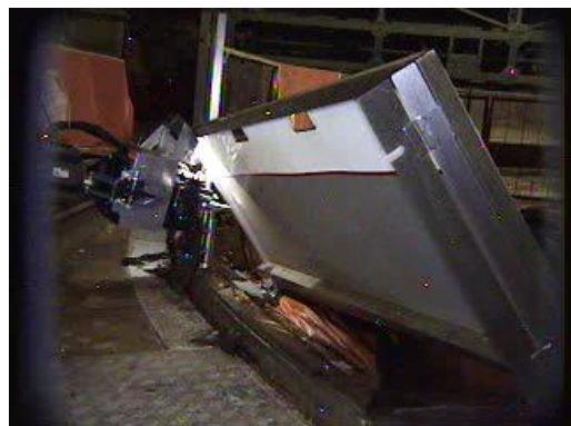
図3 フェンス脚部切断後
