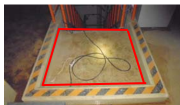
②床面 コンクリート塗装面 (未除染)
