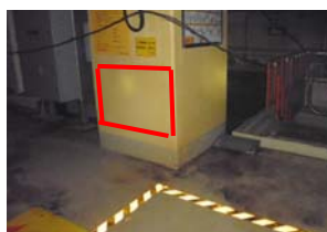
③壁面 コンクリート塗装面
