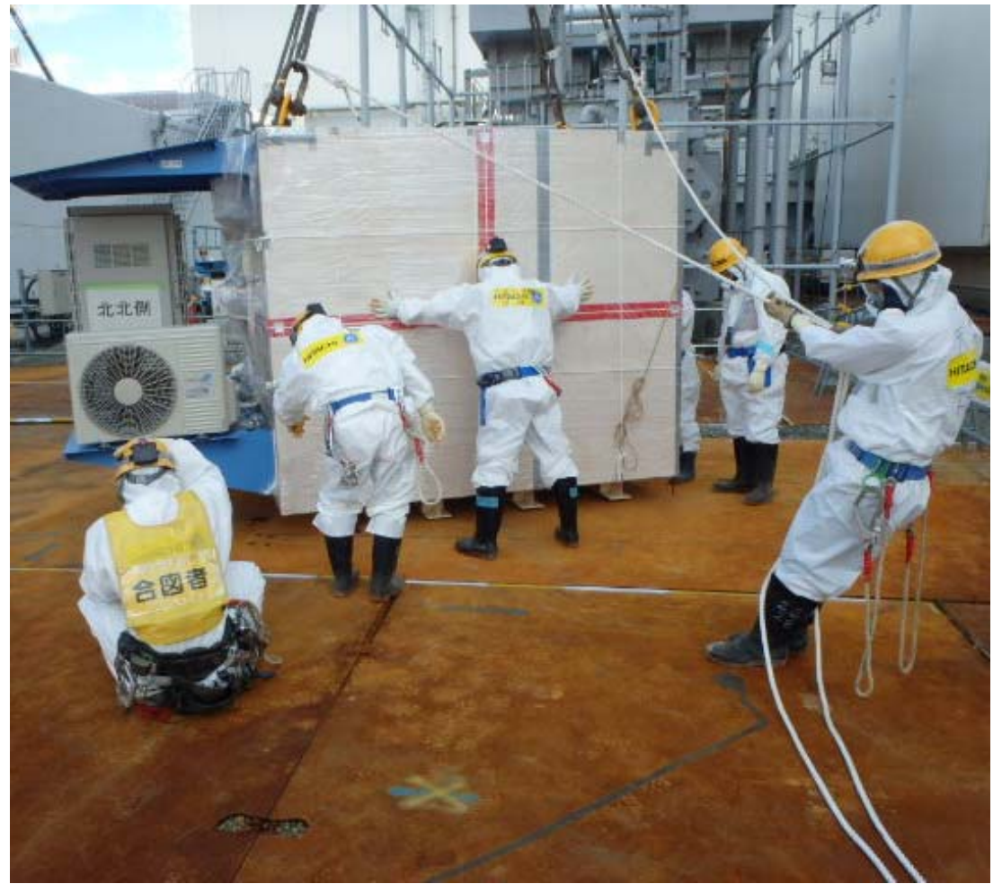
写真2 測定装置2(北側)の設置作業
