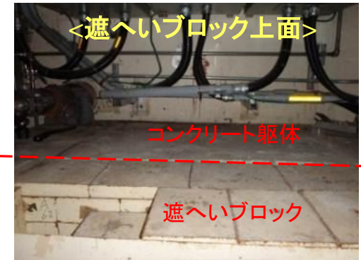
現場状況写真
