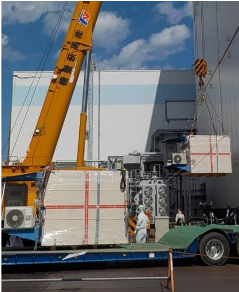
写真1 クレーンによる荷下ろし作業
