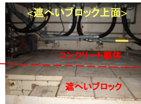
現場状況写真
