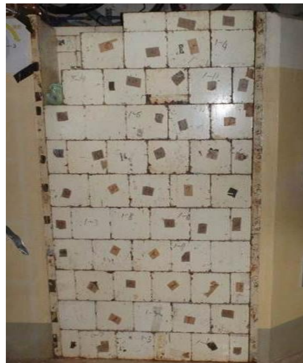
撤去前 遮へいブロック全体
