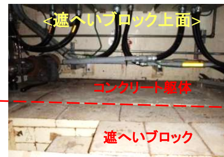
現場状況写真
