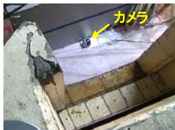
床面カメラ設置
