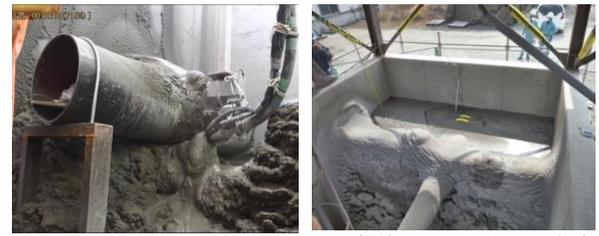
堰(配管下部)の構築 堰-躯体間への止水材の充填
