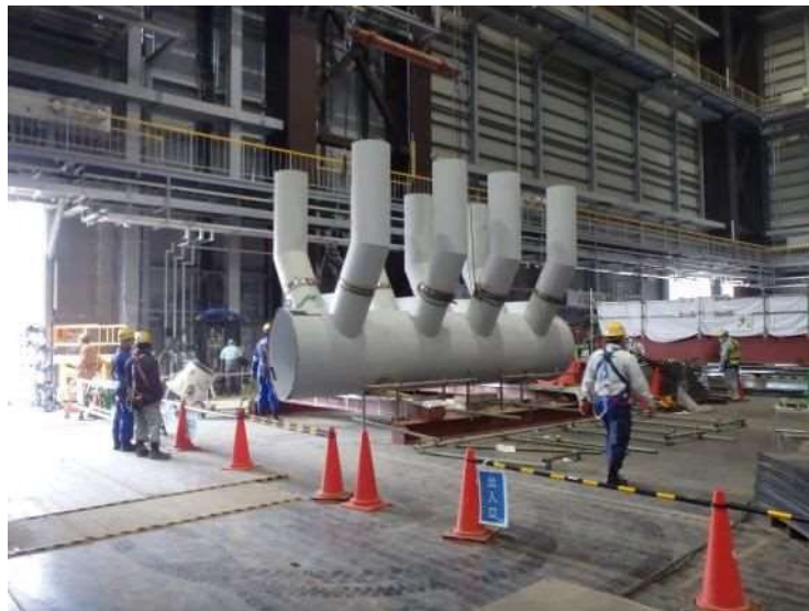
写真 2 ベントヘッダ・ダウンカマ
