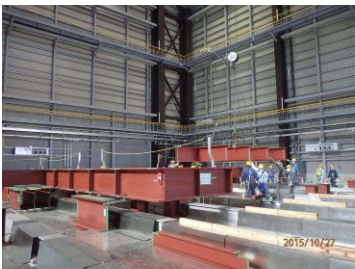
写真 3 底部架台 設置状況
