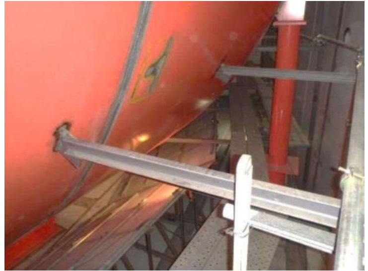
写真2 床段差コンクリート打設位置の状況
