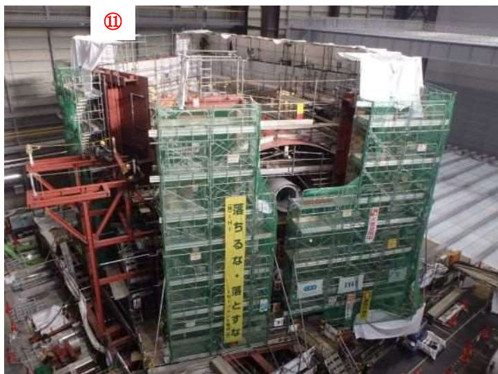
写真2 閉止壁・トーラス室壁 建込み作業(赤字番号の箇所)
