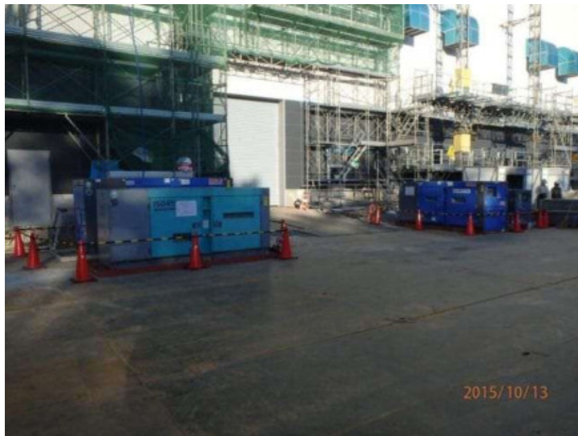
写真 2 発電機設置状況
