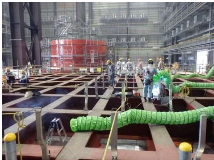
写真1 試験体用架台の組立・溶接
