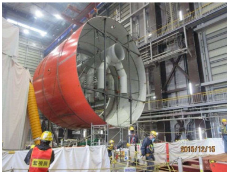
写真 1 S/C シェル(1ベイ目)の吊上げ・移動
