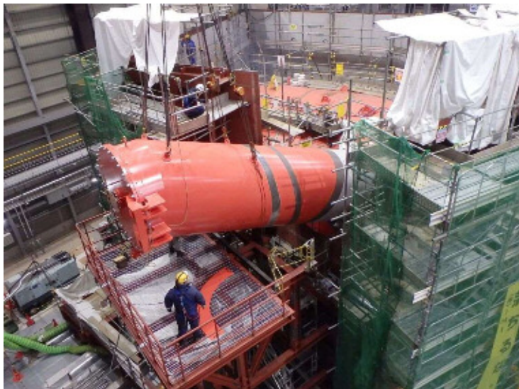
写真1 ベント管の吊上げ・設置
