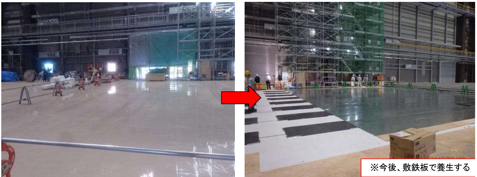
写真 3 組立エリアの床を養生(左:養生前、右:養生後)
