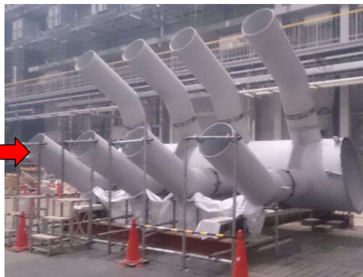
写真2 ベントヘッド・ダウンカマの組立
