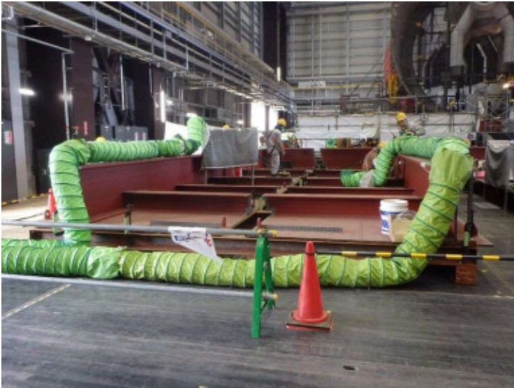
写真 2 閉止壁、トラス室壁の地組立
