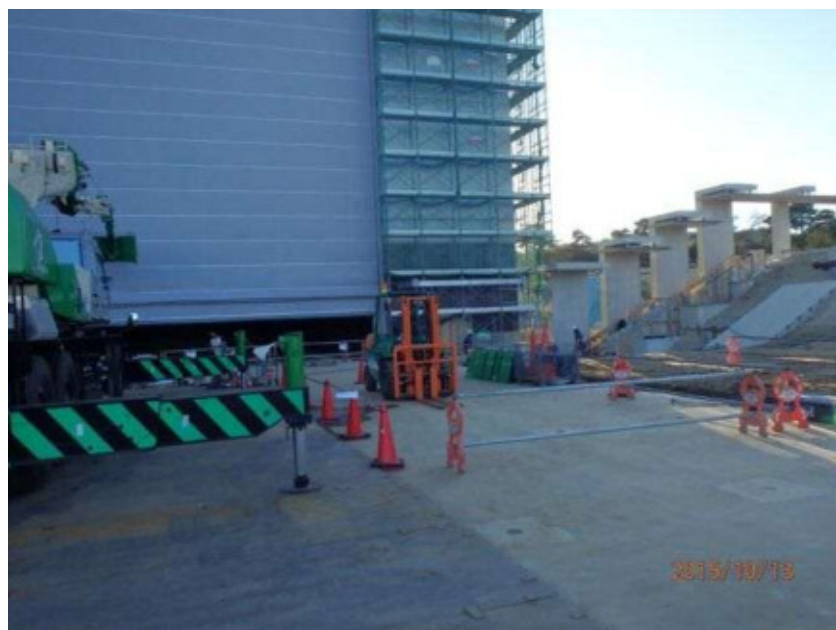
写真 3 解体ヤード仮置き状況
