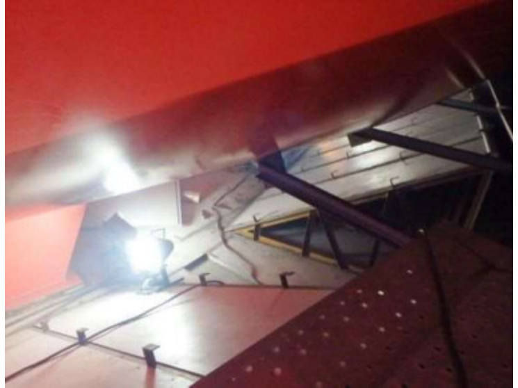
写真2 底部 床段差型枠の取付け状況
