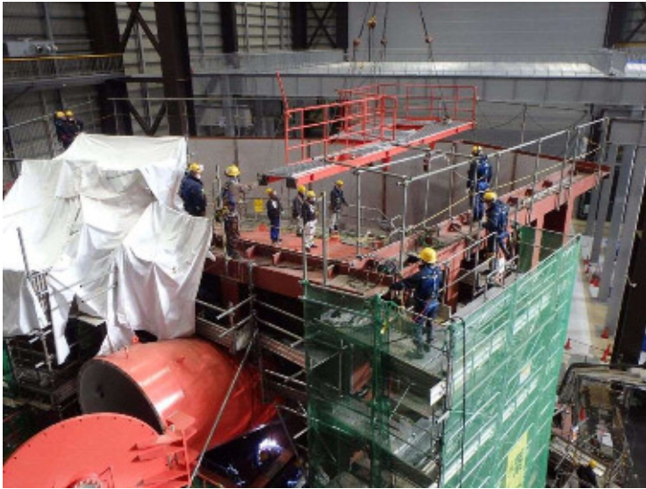
写真1 S/Cシェル上歩廊の取付け状況
