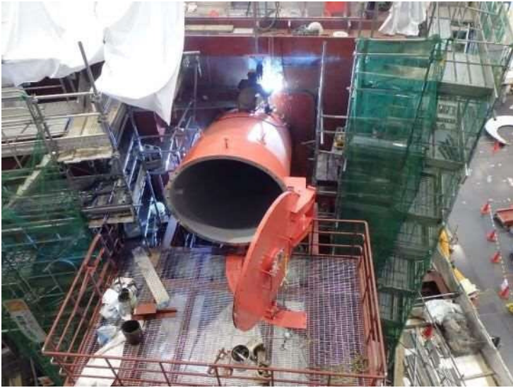
写真1 ベント管取付けの状況
