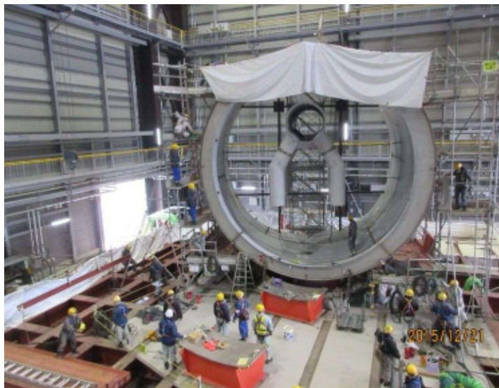
写真 1 S/C シェル(1ベイ目)の足場組立・位置調整
