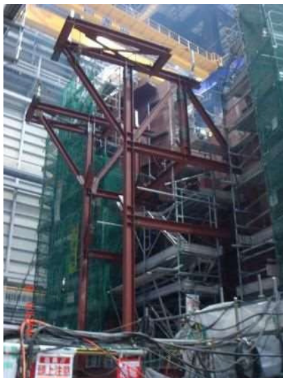
写真1 ベント管支持架台の建込み
