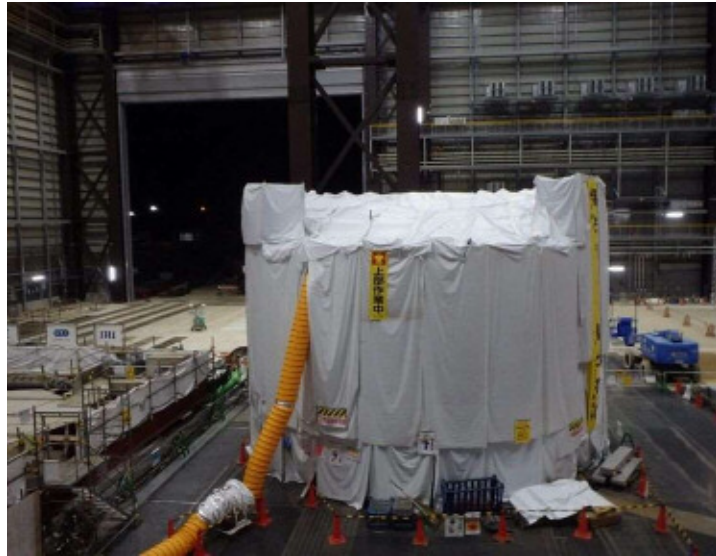
写真1 S/C シェル(2ベイ目)を組立後の養生の状況
