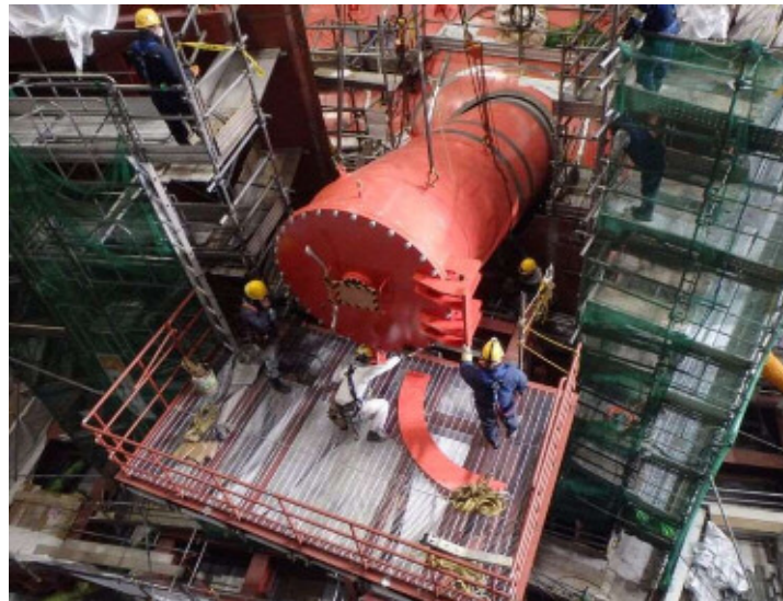
写真1 ベント管の吊上げ・設置
