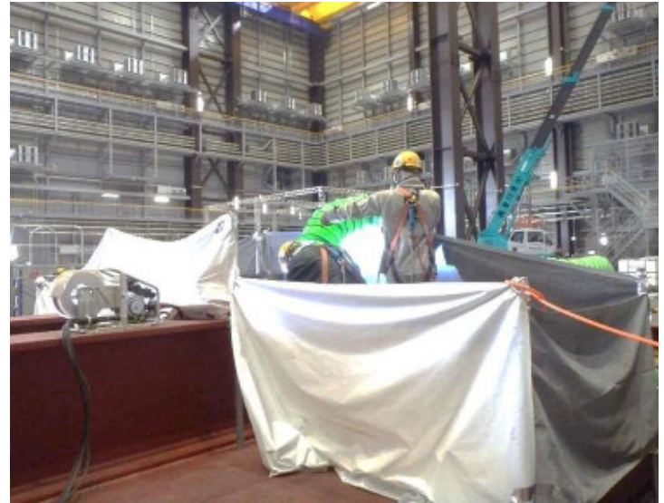
写真 2 閉止壁、トラス室壁の地組立
