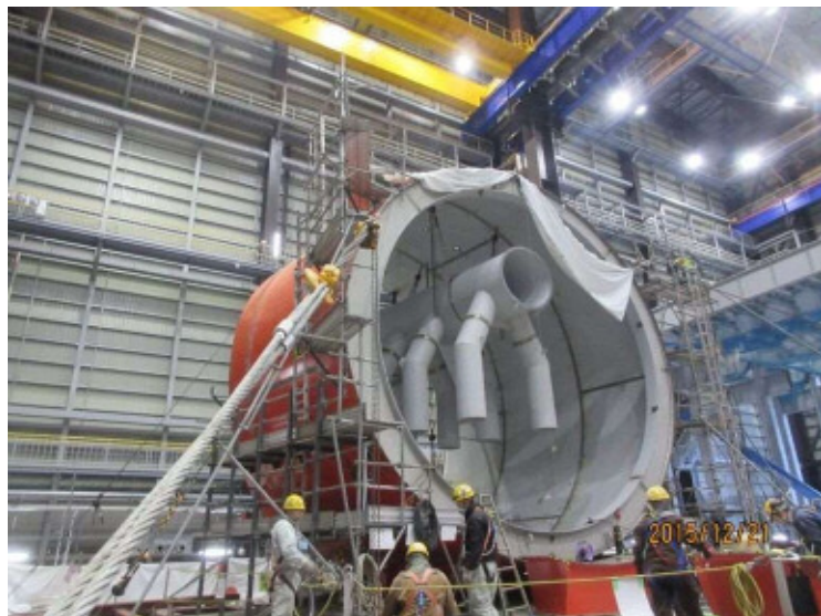
写真 1 S/C シェル(1ベイ目)の足場組立・位置調整
