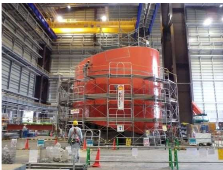
写真2 S/C シェルの設置
