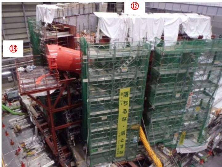
写真2 閉止壁・トラス室壁 建込み作業(赤字番号の箇所)
