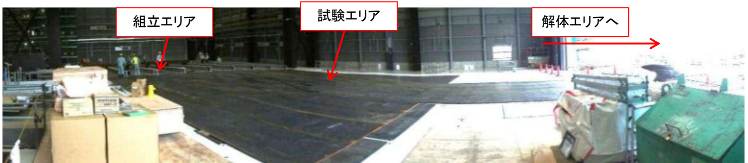
写真 2 試験エリアから解体エリアまで養生
