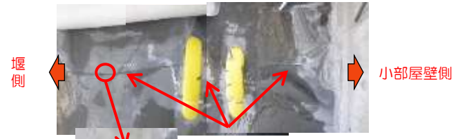
止水材の天端に発生したひび割れ
