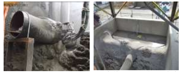
堰(配管下部)の構築 堰-躯体間への止水材の充填
