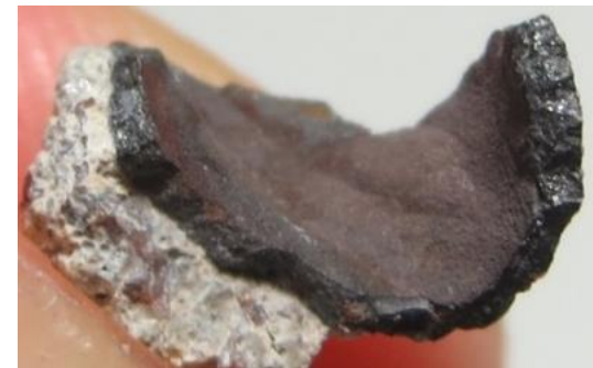
上図: はがれた腐食生成物(剥離物)
