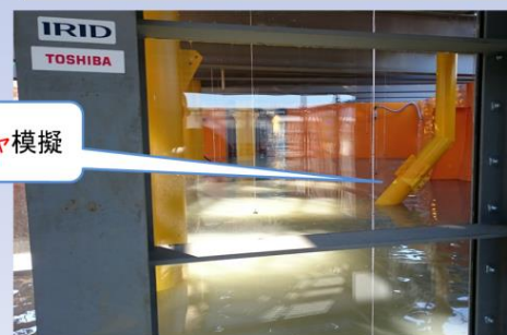
工場試験(コンクリート打設中)
