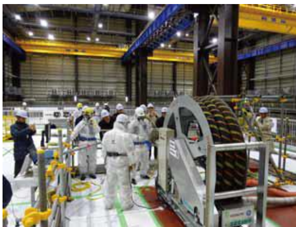
S/C脚部補強施工性確認試験
