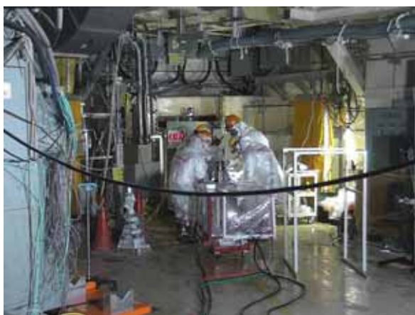
PCV外部 (X-6ペネ) 前での作業
