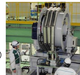
炉内構造物穴開け アクセス装置
