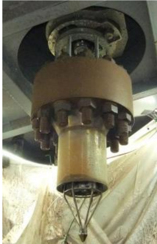
RPVノズル(上部)切断片撤去
