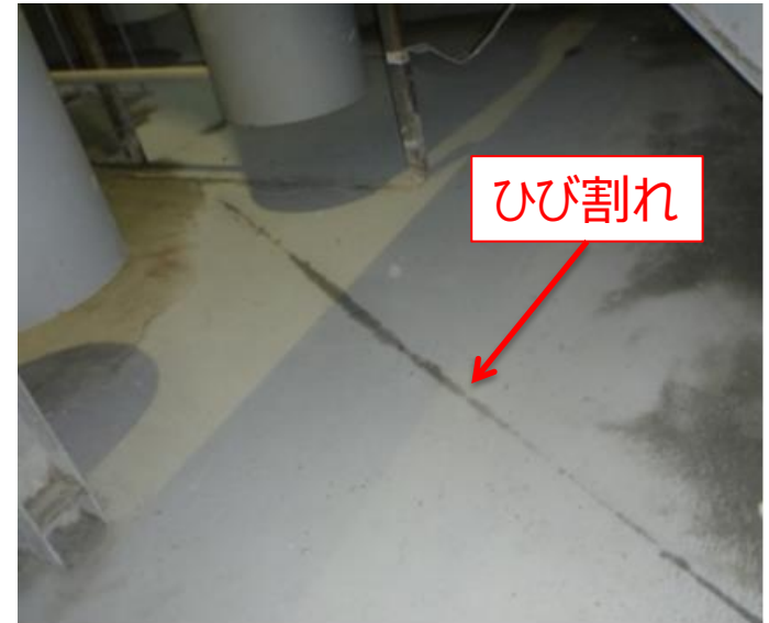
S / C 脚部補強材打設後、 止水材を横断・貫通するひび割れを確認
