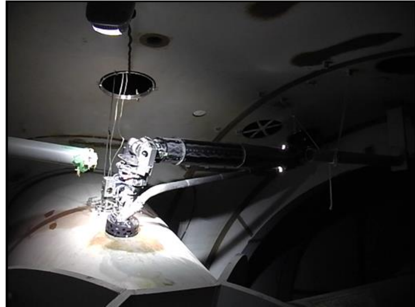
副閉止補助材ツール設置試験
