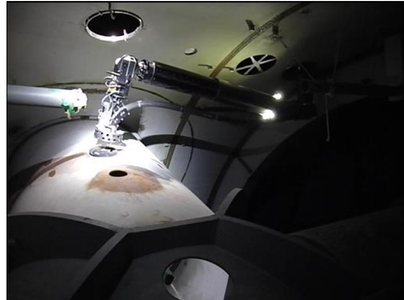
止水材用ツール設置試験
