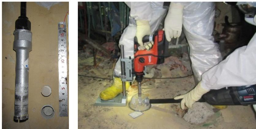
図15 遠隔操作を考慮した工具(左)と4号機原子炉建屋(2階南西側通路)におけるコンクリートの採取作業(右)
