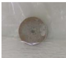
コンクリートコア外觀 (4RB-1F-C-E2)
