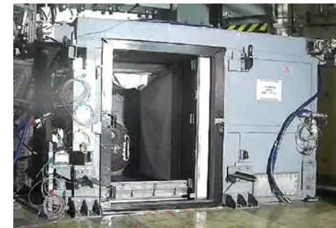
ハッチ隔離部屋設置後の写真
