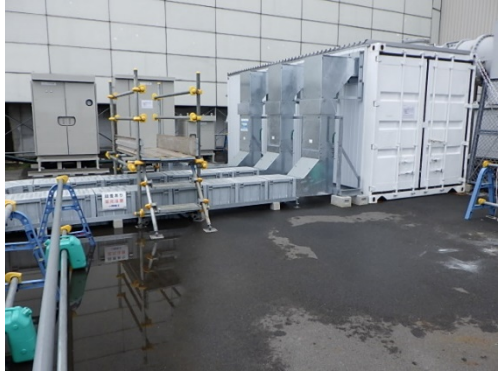
図4.5-3 : A視 施工後
