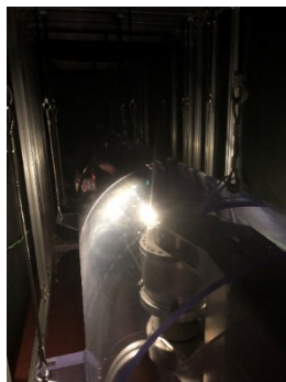
アーム設置LEDライトの状況(暗所)
