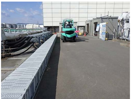
図4.5-2 : A視 施工前
