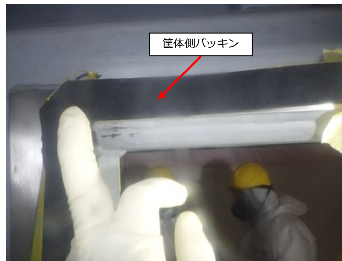
改良型パッキンの取付状況
