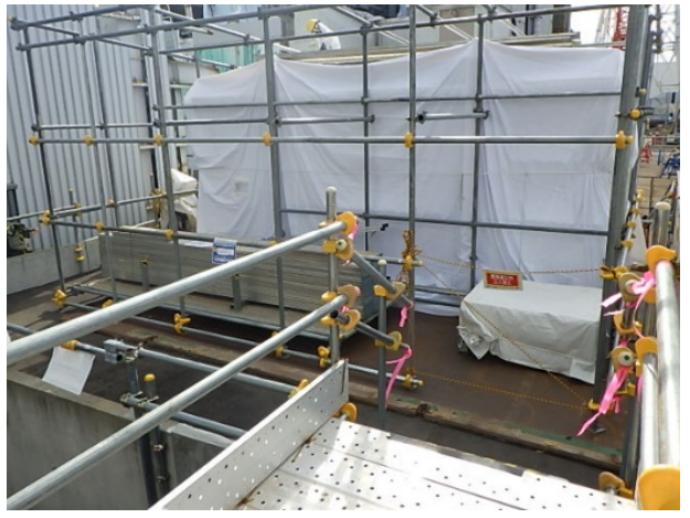
図4.5-13 新現場本部（シート養生）
