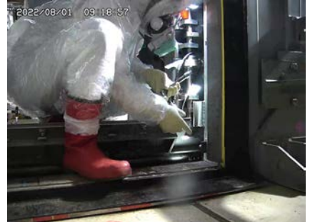
防滴型LSと現地交換作業状況
