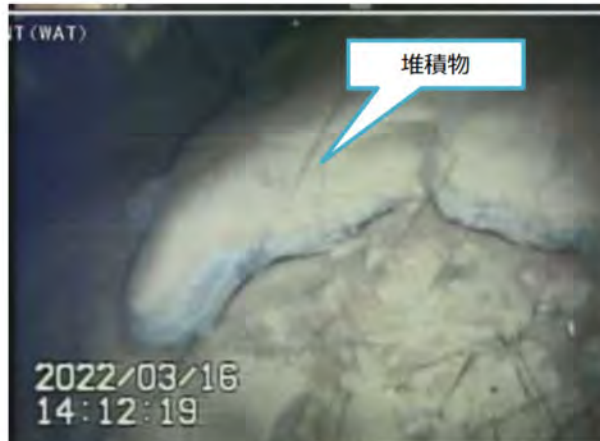
写真2.ジェットデフレクター(F)付近の状況
