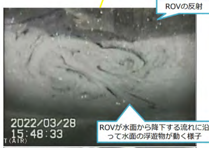
写真3.地震後に確認された水面の汚れ
