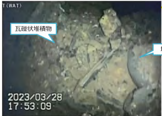
写真2.ペDESTAL内開口付近堆積物
