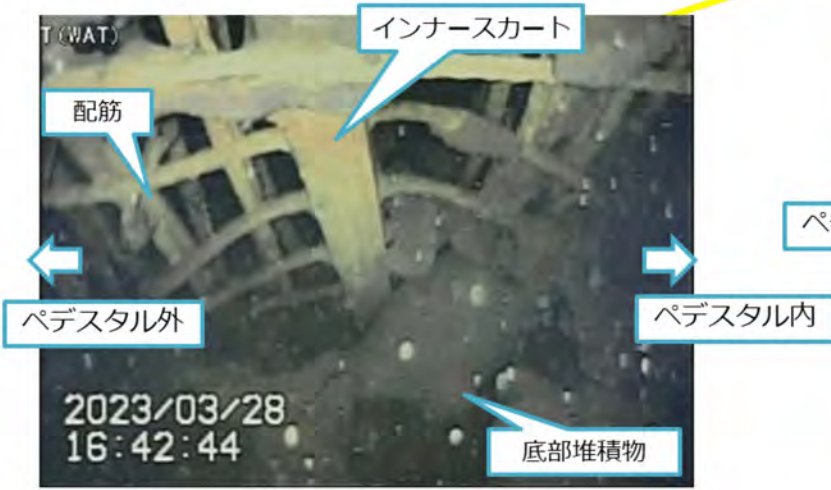
写真2.ペDESTAL開口左側配筋
