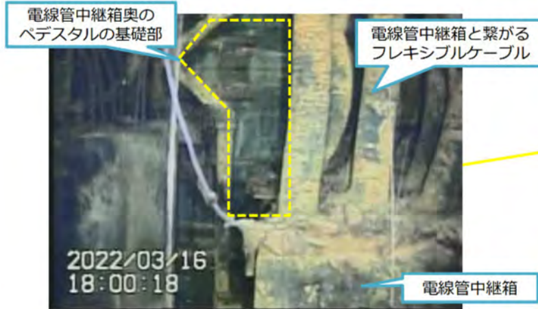
写真1.ペDESTAL基礎部付近の状況①
