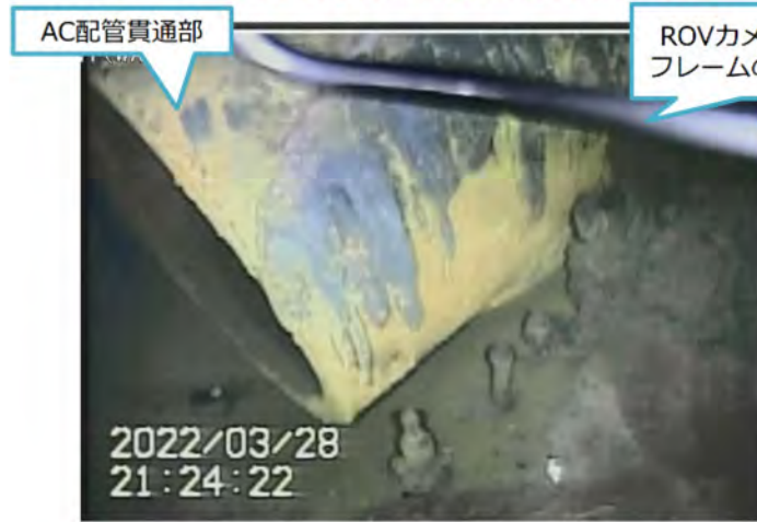
写真2.AC配管貫通部の状況
