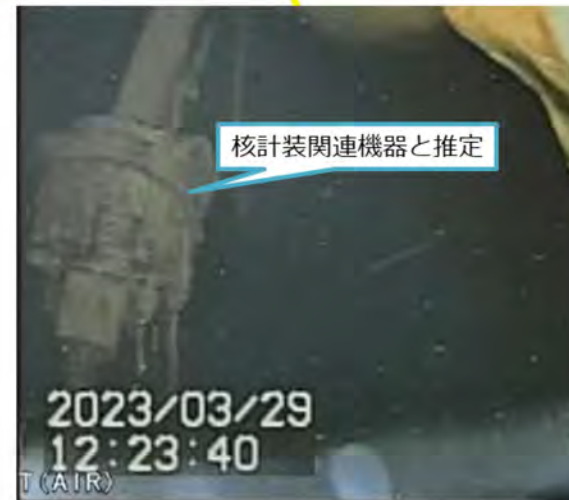
写真3. 核計装関連機器と思われる構造物 (前側カメラで水中を撮影)
