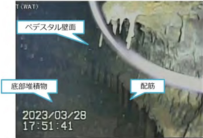
写真1.ペDESTAL内基礎部配筋
