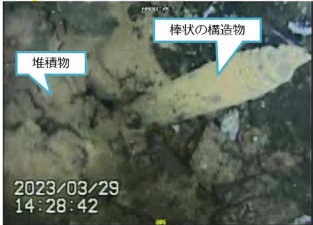
写真3.棒状の構造物(ペDESTAL底部)
