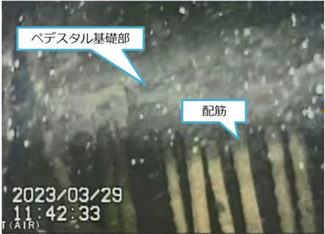
写真1.ペDESTAL内基礎部(上部)
