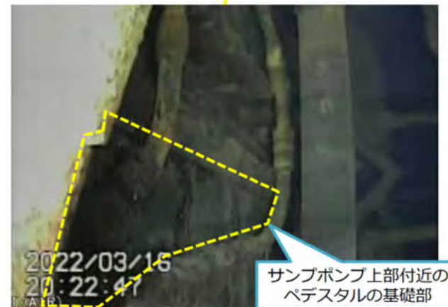
写真3.ペDESTAL基礎部付近の状況②
