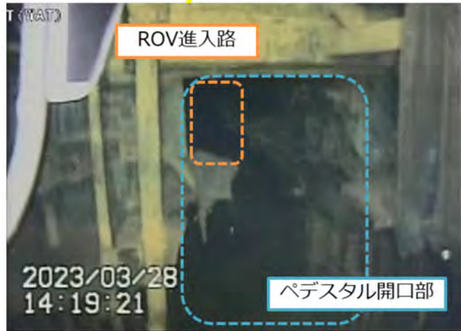
写真3.ペDESTAL開口部
