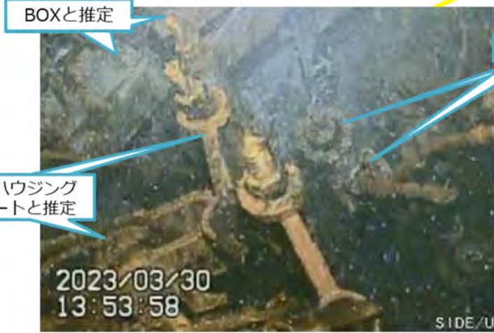
写真2. CRDハウジングサポートと思われる構造物 (上側カメラで気中を撮影)
