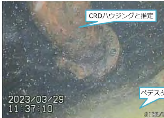
写真1. CRDハウジングと思われる構造物 (上側カメラで気中を撮影)
