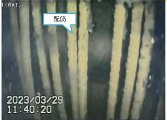
写真2.ペDESTAL内基礎部(下部)
