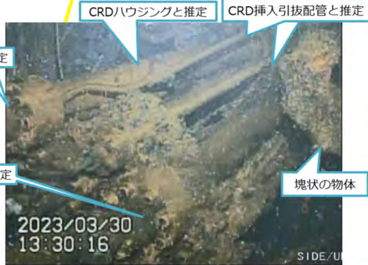
写真3. 脱落しているCRD関連と思われる構造物 (上側カメラで気中を撮影)
