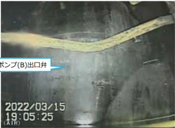
写真1.PLRポンプ(B)出口弁付近の状況
