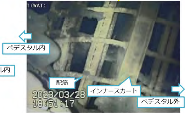
写真3.ペDESTAL開口右側配筋
