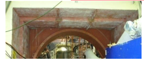
コンクリートブロック 撤去後(1F-4 X-1B)
