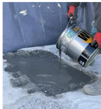
無収縮モルタル充填中
