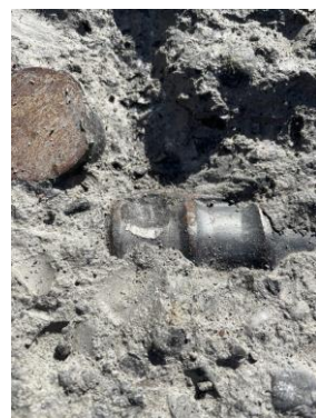
床面研り後 (解体片撤去後)
