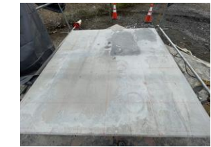
ポリリッシャーによる平滑化後
