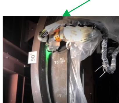
蛍光浸透液吹付状況
