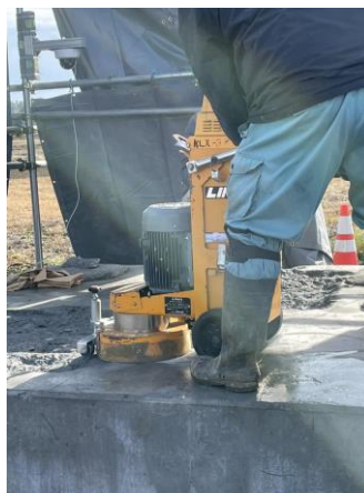
ポリッシャーによる平滑化作業
