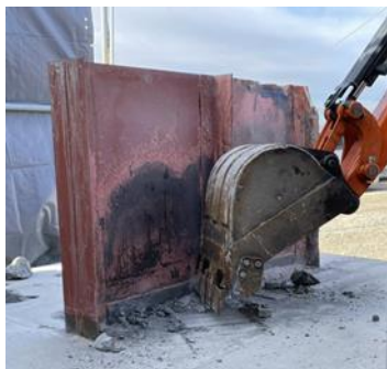
バケットによるモルタル除去
