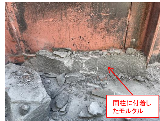
試験体側面 解体完了後
