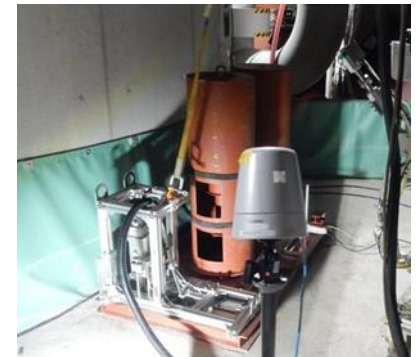
要素試験の状況(2号機PCV地下階)
