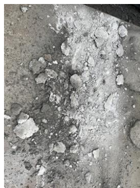
床面研り後 (解体片撤去前)
