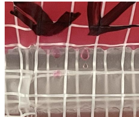
水漏れ箇所 (微小の穴から水漏れが発生)
