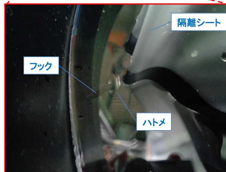
下部ドラム缶・水シール堰写真 (上の全体像は隔離シート取り付け前)
