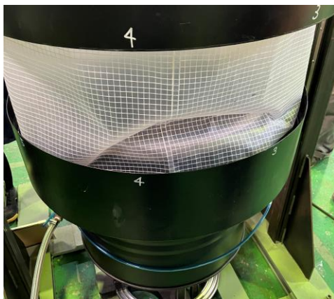
⑤下ドラム缶の水シールシート設置
