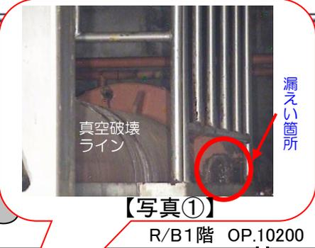
①真空破壊ラインのベローズ部分からの漏えいを確認。(写真①参照)
