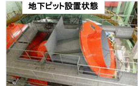
ベント管および コンクリートスリーブ部(縦置き)
