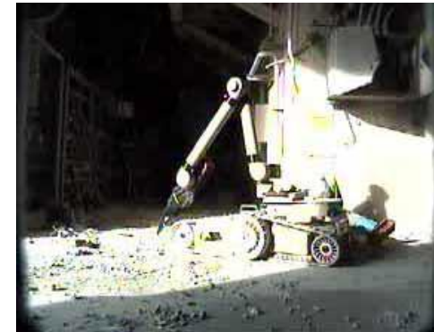
3号機大物搬入口のガレキ撤去 (2011.11.3)
