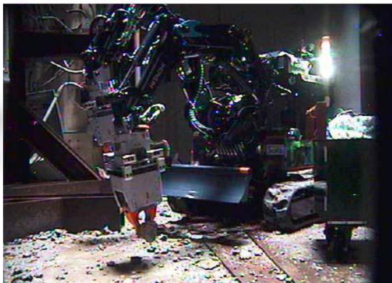
3号機大物搬入口周辺の障害物除去 (2013.7.25-8.23)
