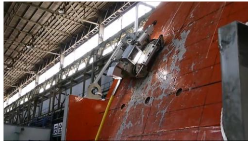
S/C上の亀裂、漏えいを調査
