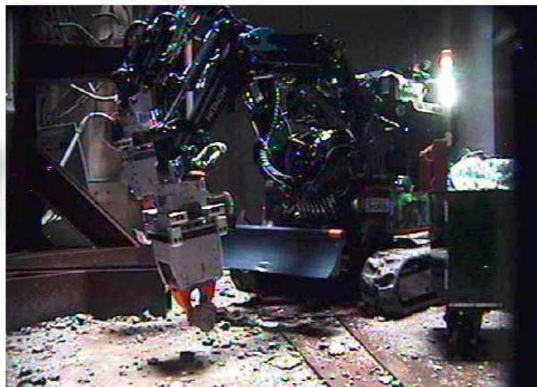
3号機大物搬入口周辺の障害物除去 (2013.7.25-8.23)
