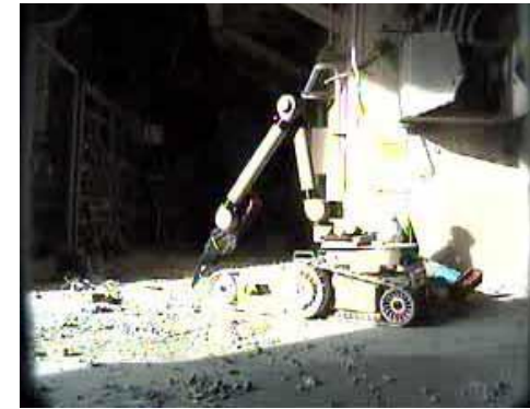
3号機大物搬入口のガレキ撤去 (2011.11.3)
