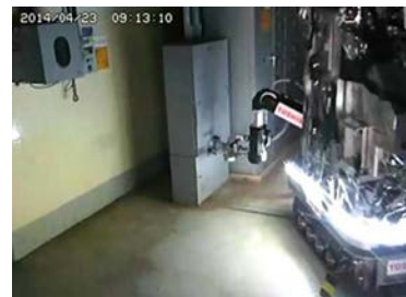
図3 実証試験の作業状況
