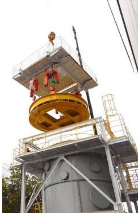
炉内装置設置時状況
