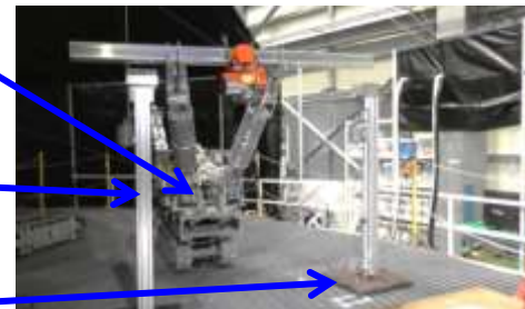
クレーン部品設置状況
