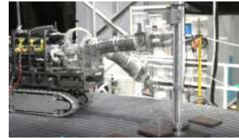
クレーン部品(支柱)設置状況
