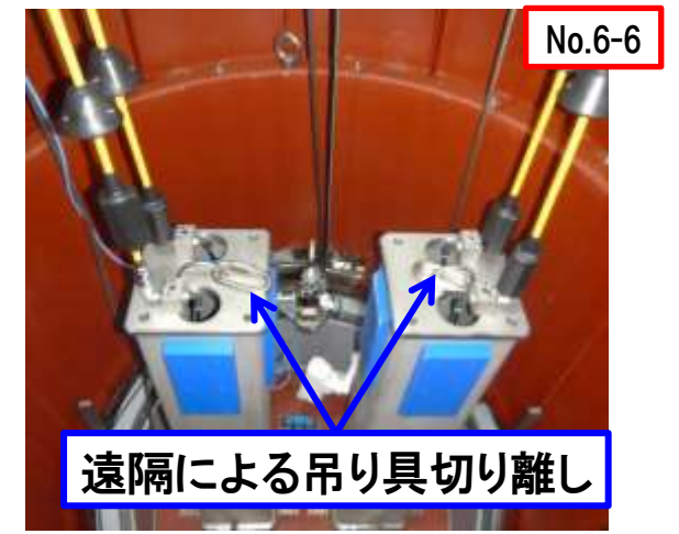
個別装置の吊り具切り離し状況
