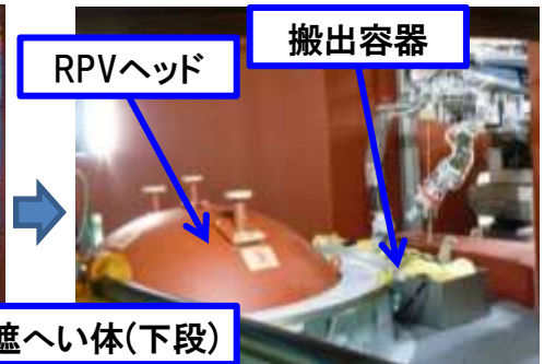
水充填式遮へい体の搬出
