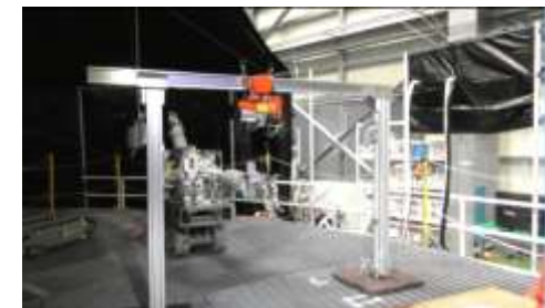
クレーン設置完了
