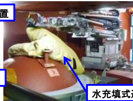
水充填式遮へい体の撤去
