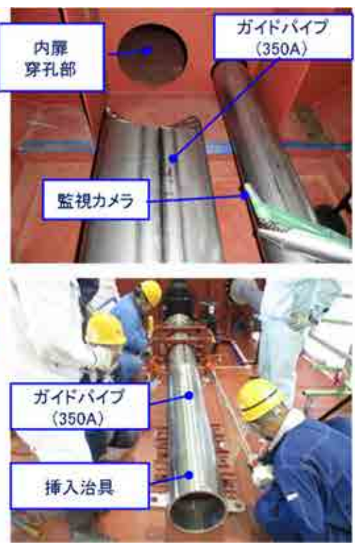
図4.2.1-4(b) ガイドパイプ挿入 (写真は350A)
