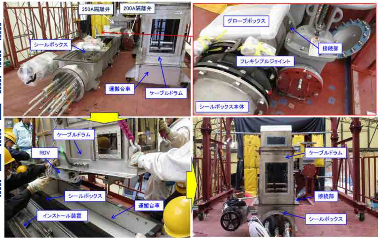
図4.2.2(1)-2 シールボックス・ケーブルドラム取付
