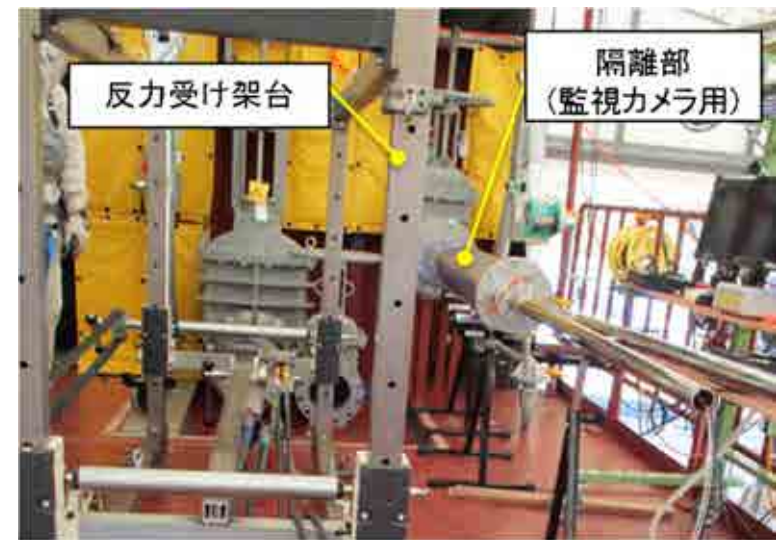
図4.2.1-2(b) 反力受け架台/監視カメラ取付※1
