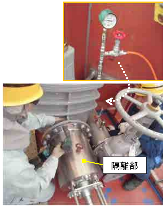
図4.2.1-2(a) 隔離部取付/リークテスト
