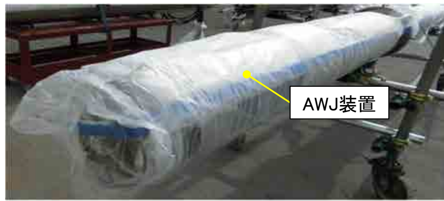
(d) AWJ装置の養生(エアロック室外搬出時の状態)
