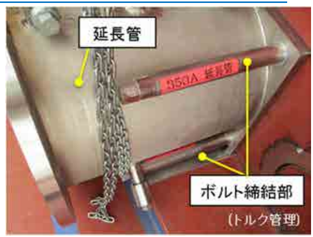
図4.2.1-1(f) 隔離弁取付
