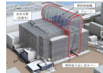
3号機プール燃料取り出し用カバーイメージ
