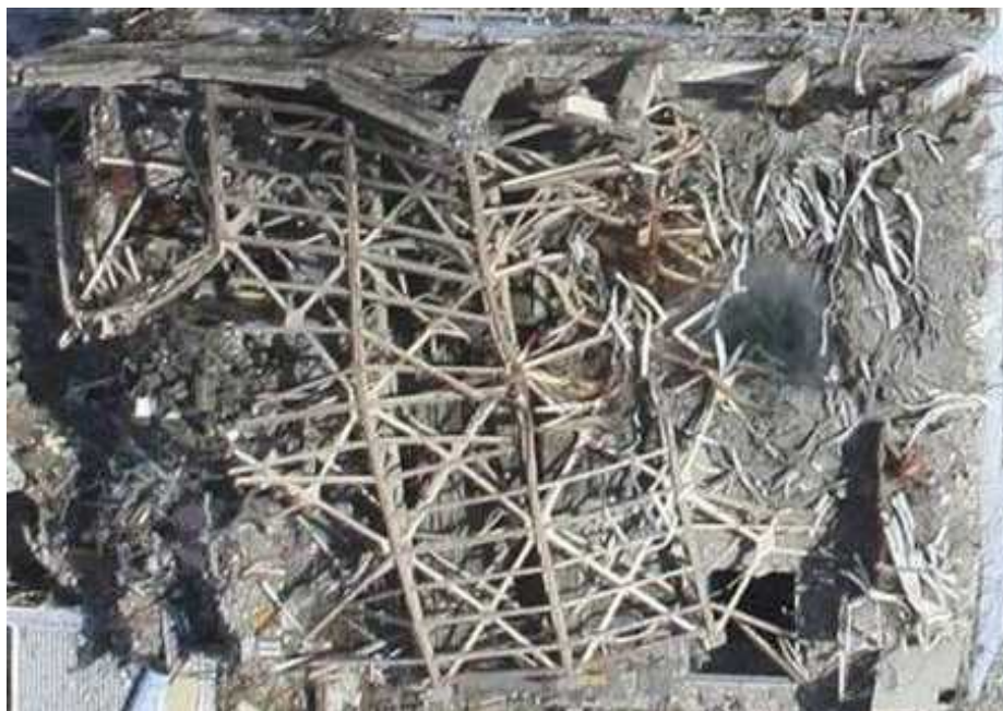
大型瓦礫撤去前
