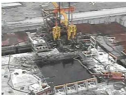
事故時に使用済み燃料プールに落下した燃料取扱機の取出し(2015年8月)
