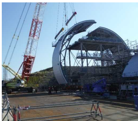
小名浜港での屋根部の組立て作業(2014年10月)
