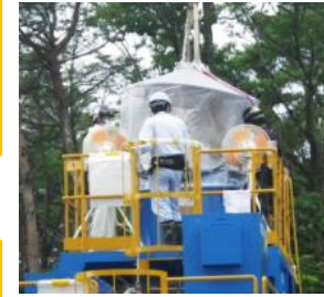
フロン投入作業
