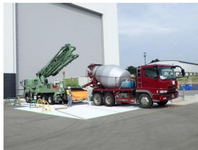
コンクリートポンプ車とアジテータ車の配置状況
