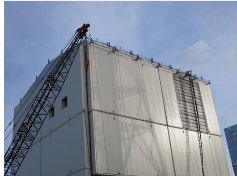
建屋カバー設置後 現在
