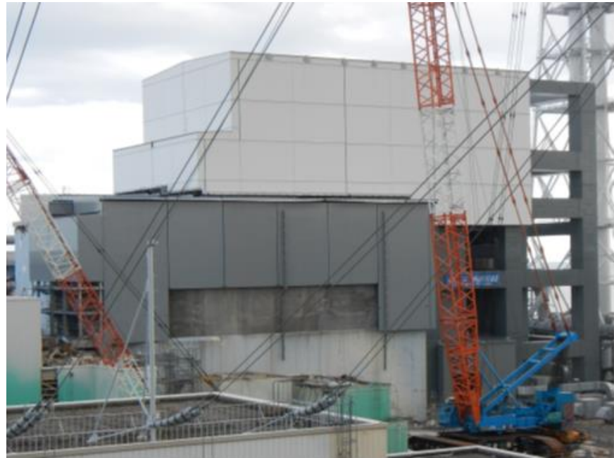
燃料取り出し用カバー構造物 現在
