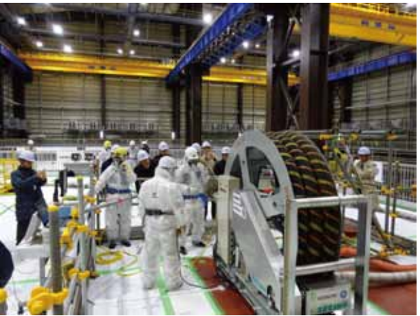
写真1 S/C脚部補強施工性確認試験の実施状況
