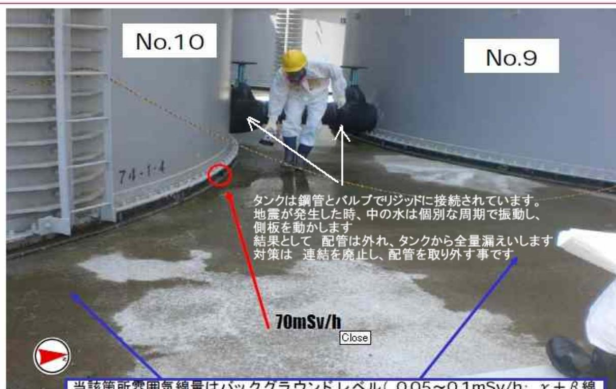
当該箇所雰囲気線量はバックグラウンドレベル( 0.05~0.1mSv/h:  $\gamma + \beta$  線 (70 $\mu$ m線量当量率) )であることから、雨水と思われる
