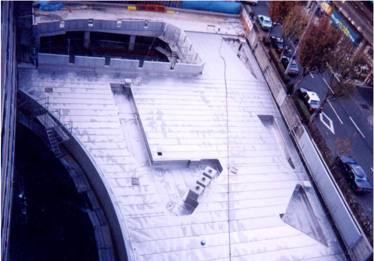
チタンシート施工画像
