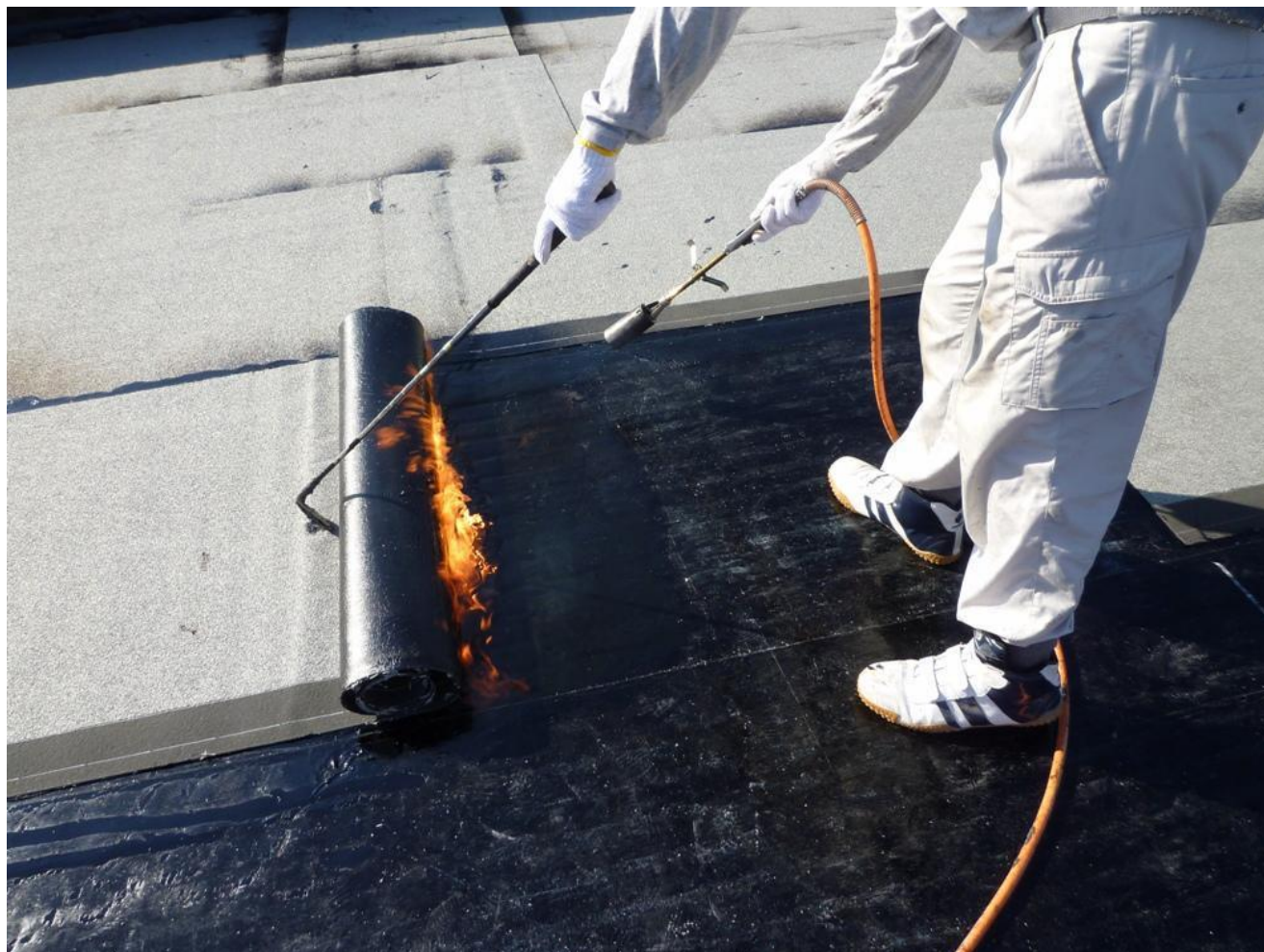
トーチ法によるゴムアスファルトの施工画像
