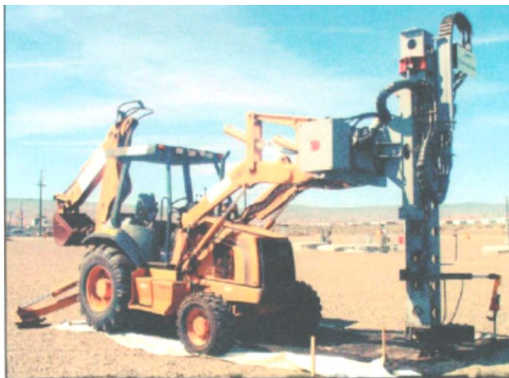
図-4 DPT 装置による注入例
