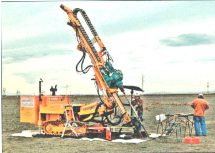
図-3 DPT 装置によるドリル例
