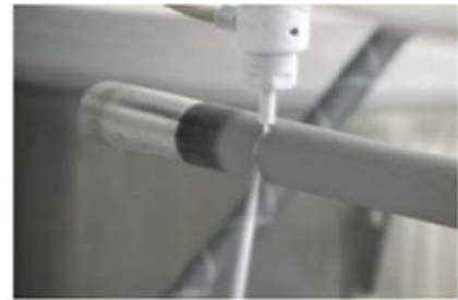
SUS 配管の切断例
