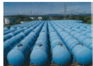
横置きタンク設置状況
