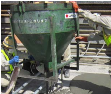
スリムクリートのポケット打設状況
