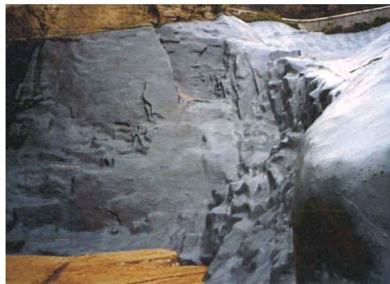
④法面凹凸部への施工状況
