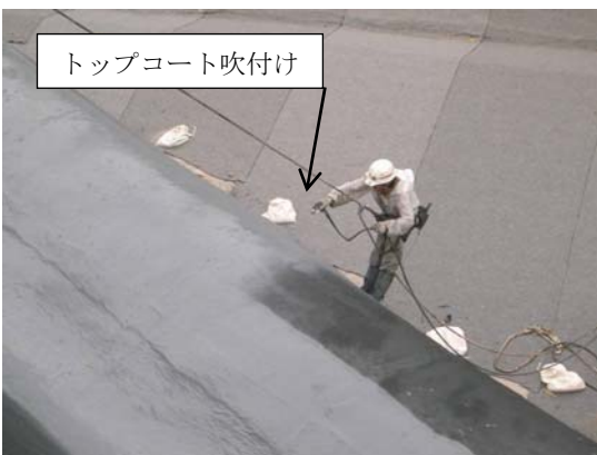
③吹付けシート表面への保護層の吹付け
