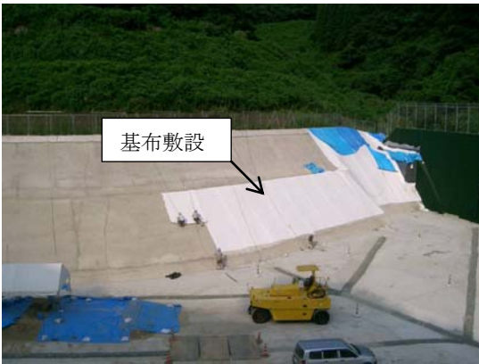
①法面部への基布の敷設
