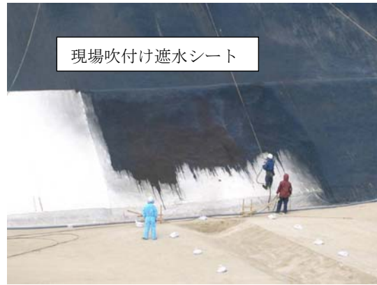
②基布へのゴムアスファルトの吹付け
