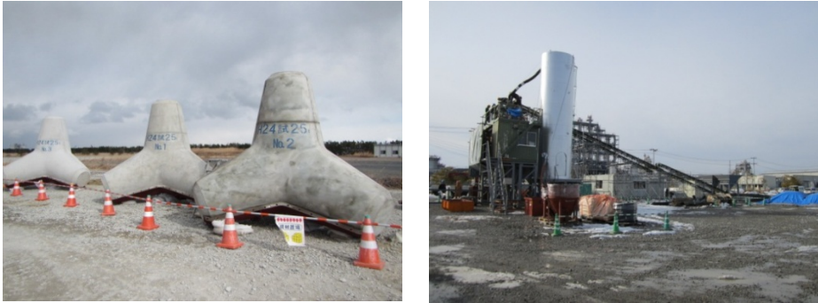
図-3 福島県相馬港震災復興工事で海水コンクリートを使用した 消波ブロック及び、海水コンクリート製造プラント
