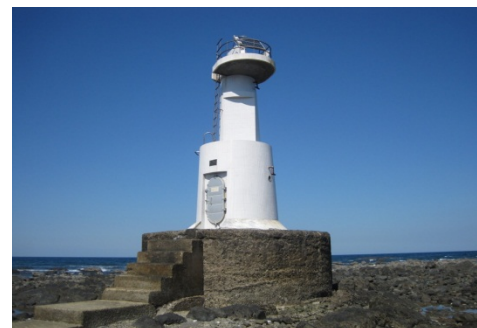
図-2 築後50年経過した海水・海砂を使用した鉄筋コンクリート構造物
