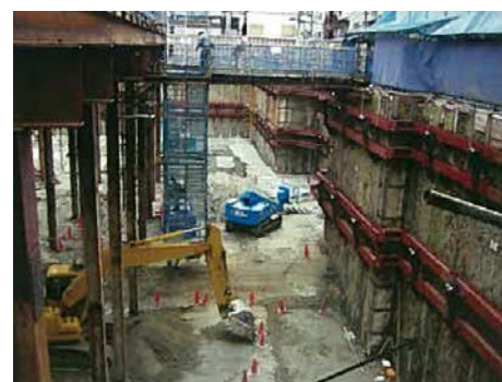
建築現場におけるSMWの実施例 (地下水位GL-4m、基礎底GL-12m、壁からの湧水なし)
