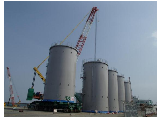
陸揚げされたタンク
