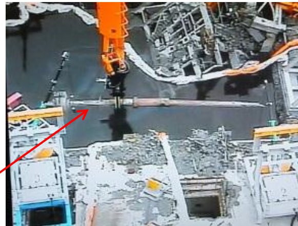
燃料交換機マスト撤去(H26.3.27)
